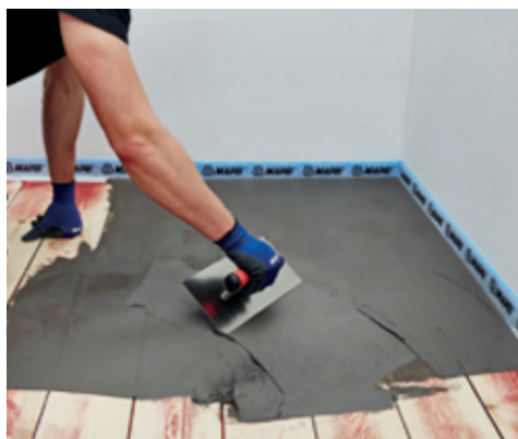
Aanbrengen van Planipatch Xtra + Latex Plus op een houten ondergrond
