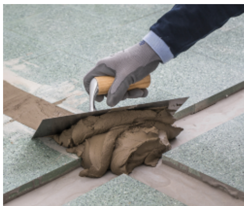
Een kabelloop vullen met Planipatch Xtra
