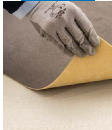
Installatie van vloeren op polyurethaan basis met Ultrabond Eco V4 Evolution
