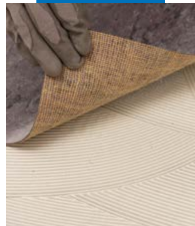
Installatie van Linoleum met Ultrabond Eco V4 Evolution
