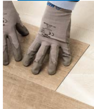
Installatie van LVT met Ultrabond Eco V4 Evolution
