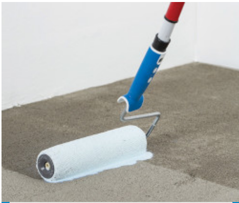
Aanbrengen van de primer op de ondergrond
